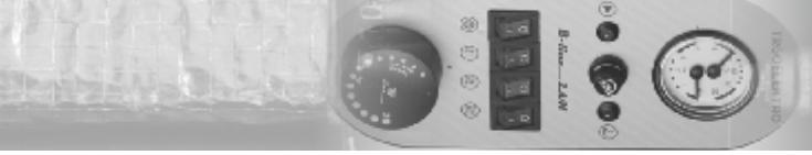
Električni kotlovi svih tipova mogu imati ugrađene trostepene regulacione termostate koji svojim potpuno automatizovanim radom uključenja i isključenja grejnih grupa u određenim intervalima štede energiju i proizvajaju radnivek uređaja.
